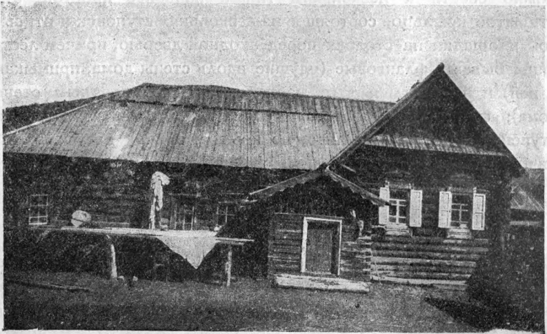
Фиг. 28. Дом И. В. Коробейникова: связь с поперечной пристройкой и крытым крыльцом; слева—сушила. Д. Белая.
