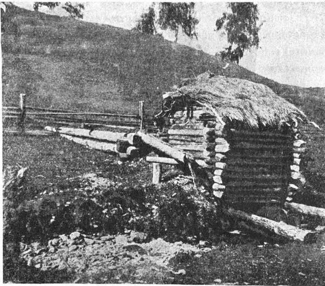
Фиг. 22. Мельница-мутовка во время работы (щит вставлен). Д. Фыкалка.
